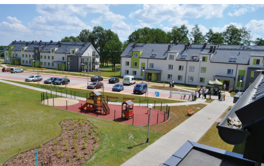
Nowo wybudowane osiedle komunalne
